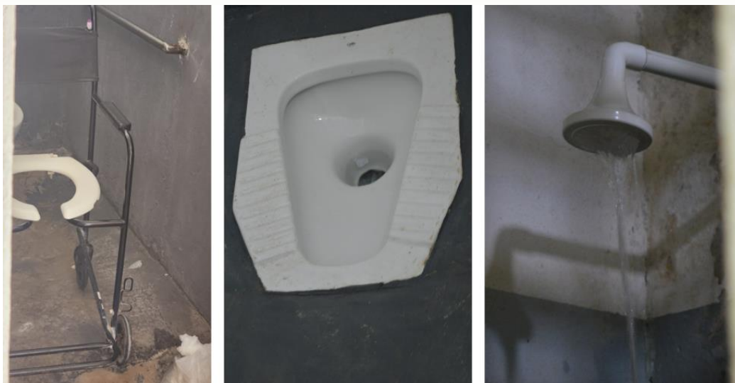
Figura 38 – Foto do sanitário e chuveiro de cela - UPRP
